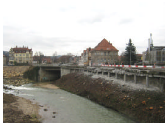
Rückbau der B29 und Abbruch der Ufermauer am Südufer der Rems
