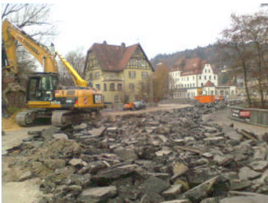
Rückbau der B29 und Abbruch der Ufermauer am Südufer der Rems
