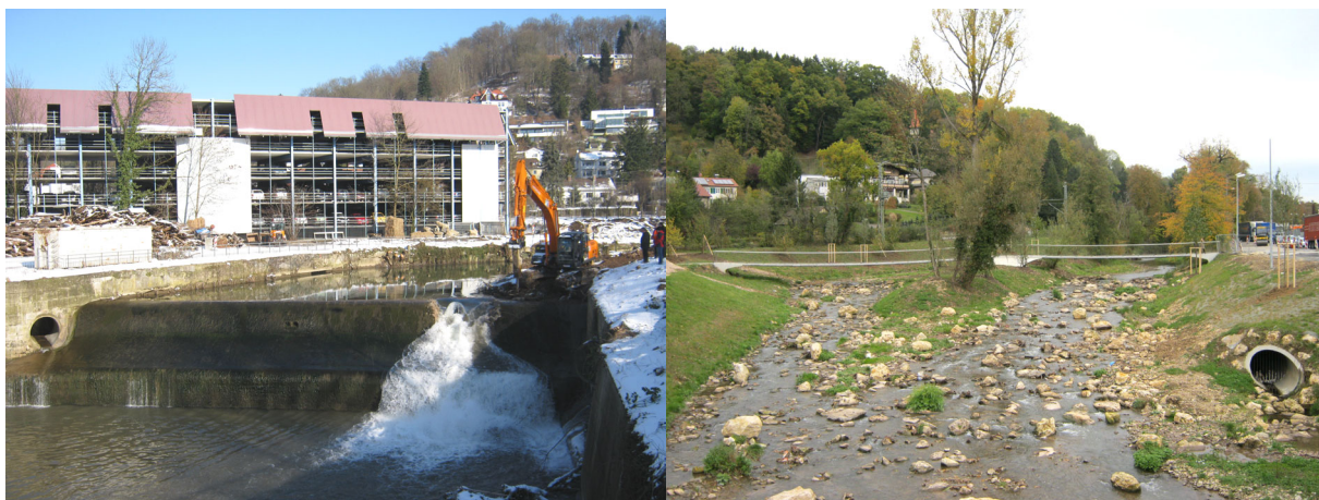
Rückbau des Wehres und neues Gewässerprofil nach der Fertigstellung
